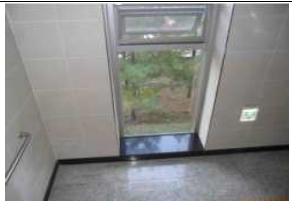
계단실 안전난간 미설치(시공현황)
