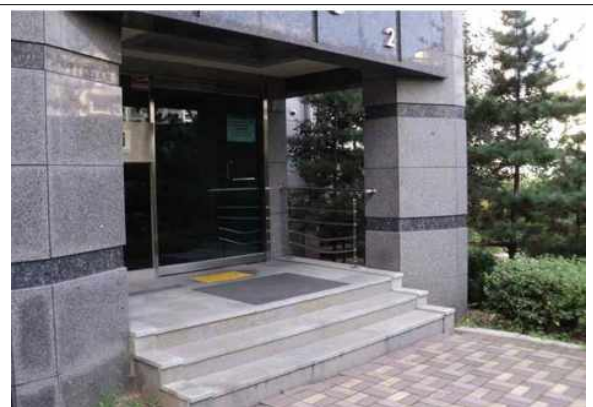
공동현황 안전난간 미설치(시공현황)
