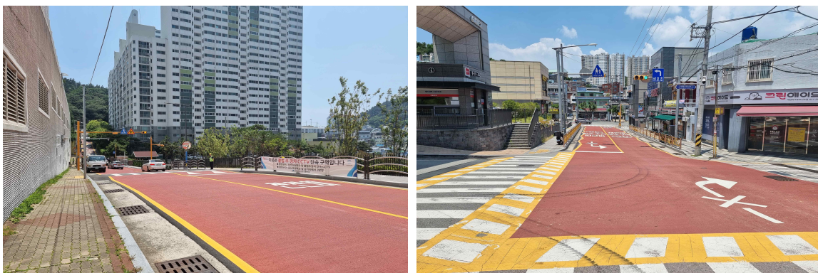
[그림 V-7] 미끄럼방지 노면요철포장 설치 사례
