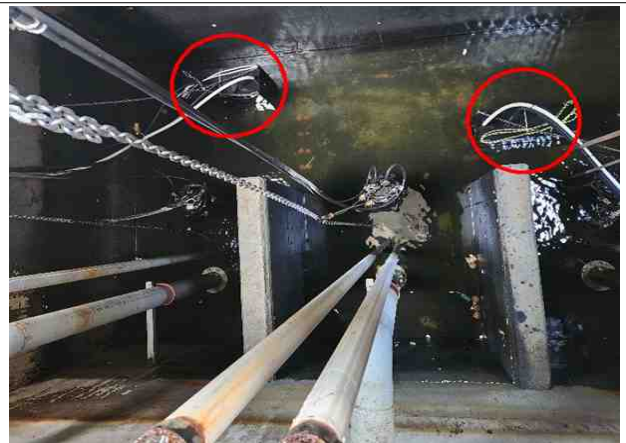
총인처리시설 방류조 내 수질개선장치 설치 완료(2024.3.)
