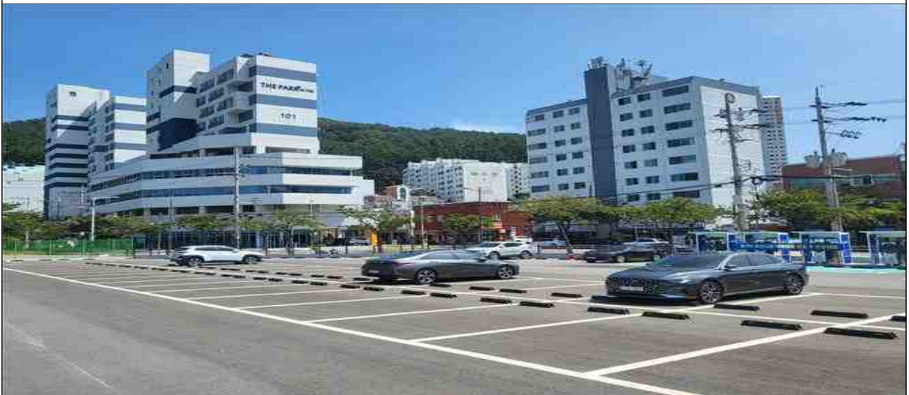
▲ 현장 사진(무가선 저상트램 실증노선 대체주차장)
