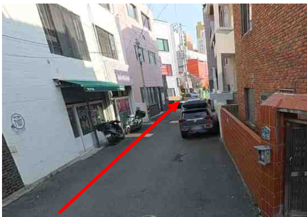
수영로219번길 일원 분류식화 지역내 배수시설 정비공사
