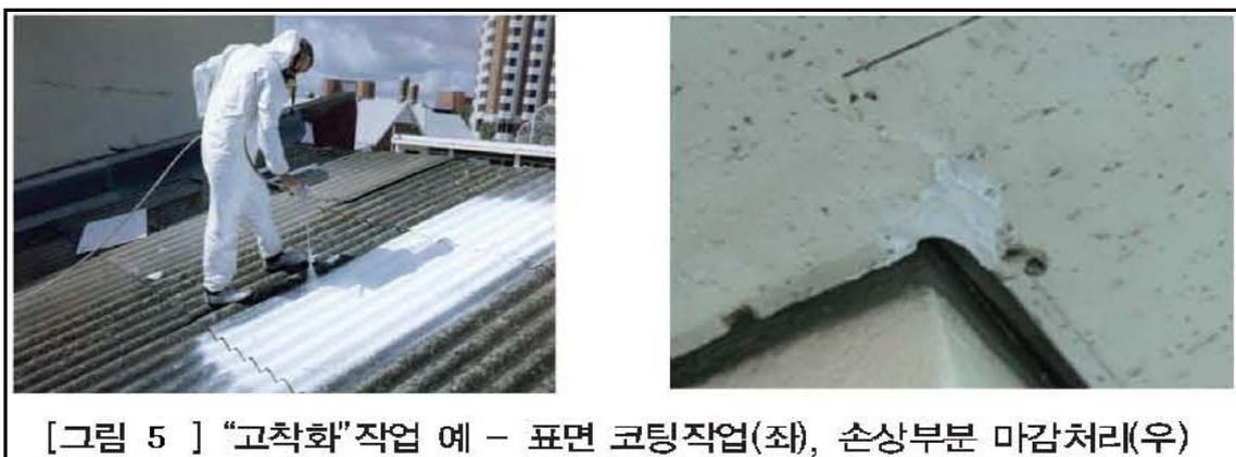
[그림 5] "고착화"작업 예 - 표면 코팅작업(좌), 손상부분 마감처리(우)
