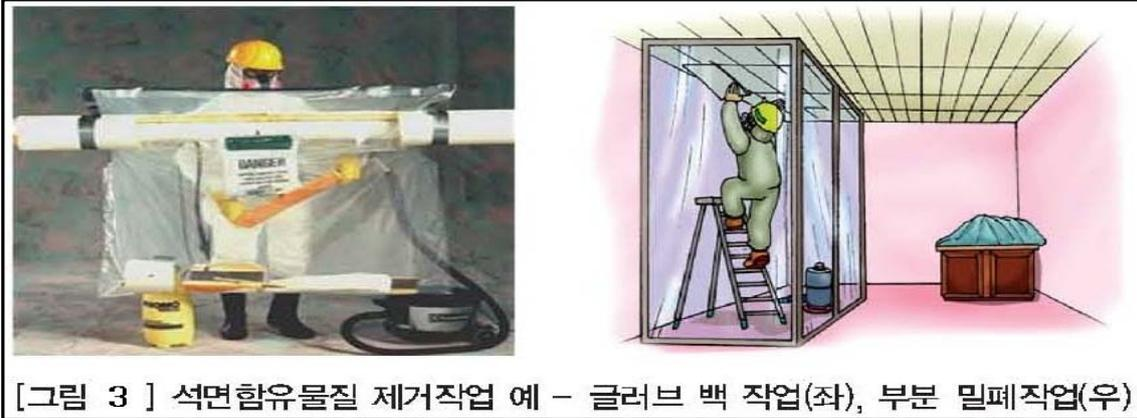
[그림 3] 석면함유물질 제거작업 예 - 글러브 백 작업(좌), 부분 밀폐작업(우)
