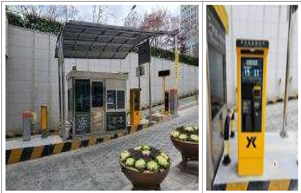
【설치완료 후 주차관제 시스템】
