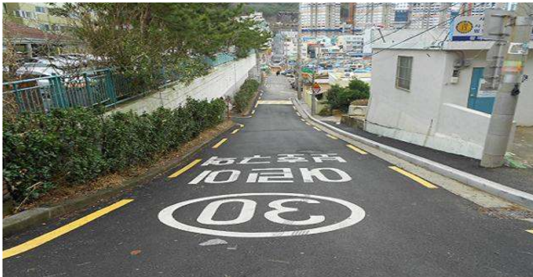
운산초등학교 앞 하수시설
