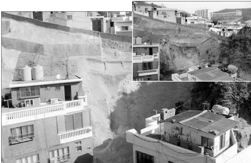
지난해 폭우로 붕괴된 우암2동 G빌라 뒤 사면에 대한 복구공사가 지난달 완공됐다. 작은 사진은 복구전 모습.
